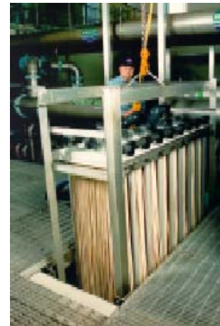
Instalación de una membrana Szegeed en el tanque del proceso ZeeWeed
