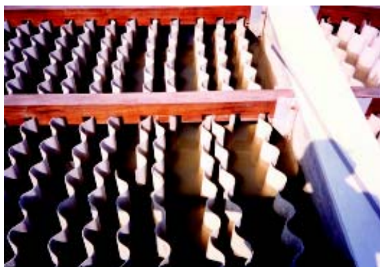
Figura 3-12. Floculador de pantallas de flujo horizontal (7)
