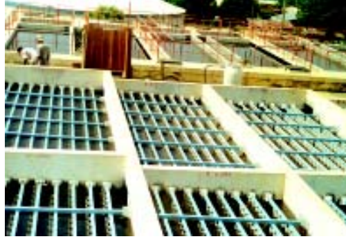
Figura 3-13. Floculador de pantallas de flujo horizontal (7)
