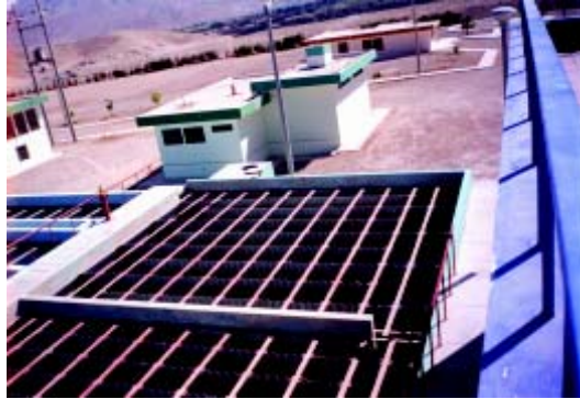
Figura 3-2. Floculador de pantallas de flujo horizontal (7)
